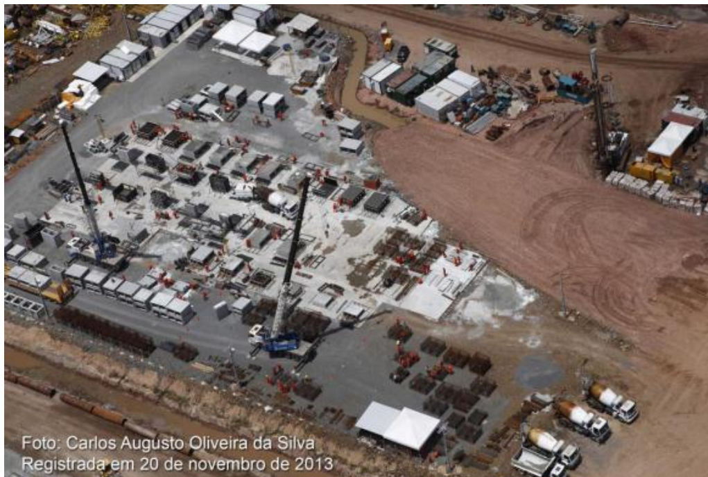
Figura 15 - Canteiro de Obras do Estaleiro (20 de novembro de 2013)
