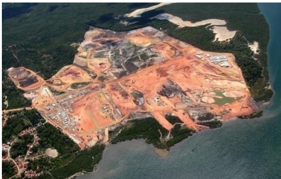
Figura 14 - Canteiro de Obras após o início da implantação do Estaleiro
