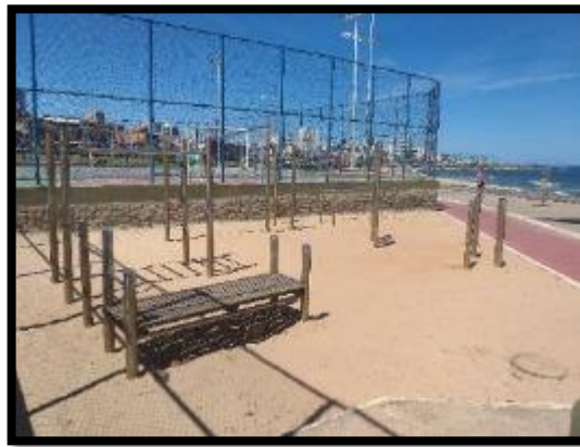
Figura 61: Equipamentos instalados sobre terreno de areia no Jardim dos Namorados.
