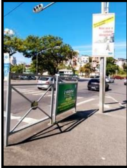
Figura 28: Obstruções na calçada da Praça João Mangabeira/Barris
