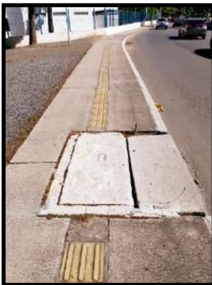
Figura 36: Piso direcional com relevo desgastado e interrompido sem alerta
