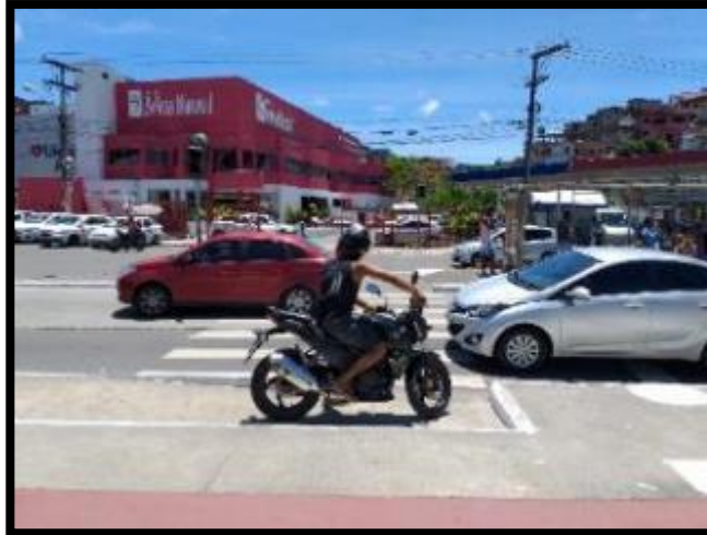
Figura 45: Rampa de acesso sem piso tátil de alerta e obstruída na Praça Luiz Gama.
