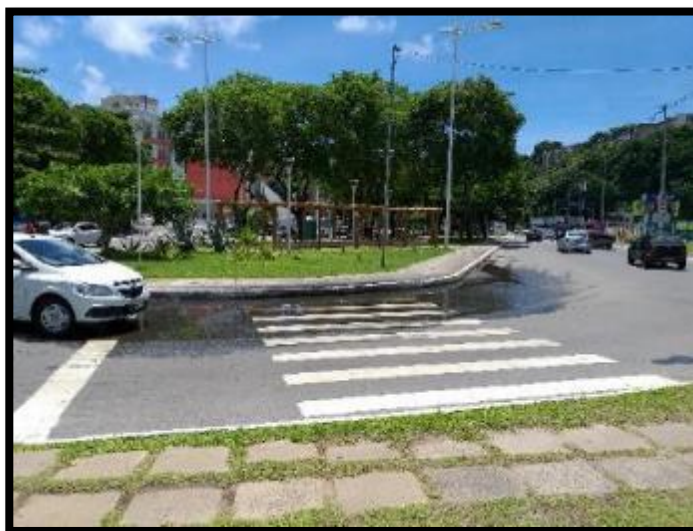
Figura 48: Calçadas interligadas por faixa de pedestres obstruída junto à Praça São Brás
