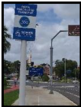
Figura 52: Obstruções irregulares por placas de sinalização na área de livre circulação da Praça Lorde Cochrane.
