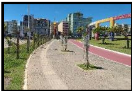
Figura 49: Trecho de calçada em boas condições de deslocamento no Parque jardim dos Namorados
