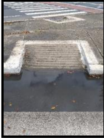
Figura 41: Rampa obstruída por água retida junto à Praça Lorde Cochrane
