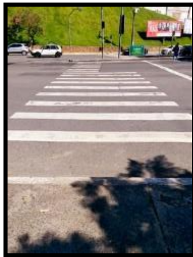
Figura 29: Faixa estreita e sem rampas na entrada da Praça João Mangabeira
