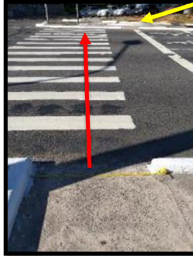
Figura 43: Falta de linearidade entre rampas junto à Praça João Mangabeira
