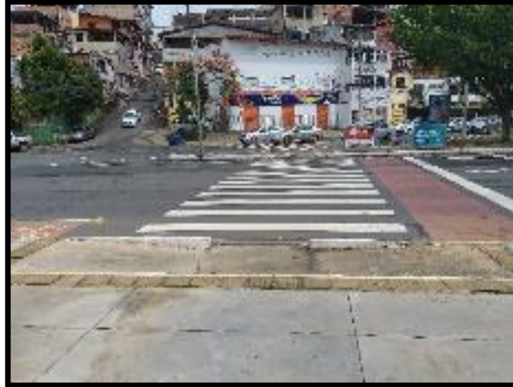
Figura 40: Sinalização tátil nas extremidades das faixas de pedestres
