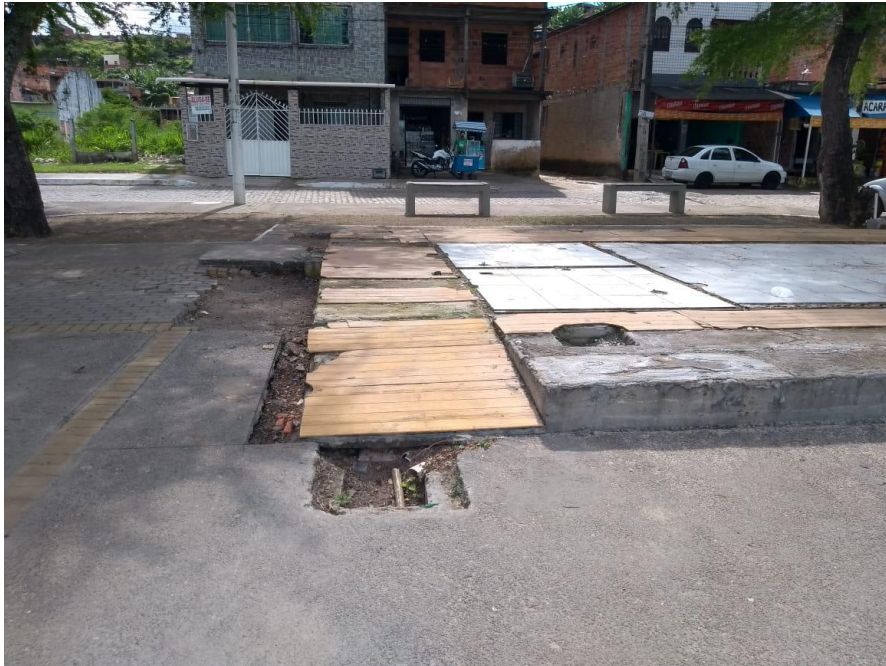
Figura 25 – Fotografia de uma rampa sem manutenção para o acesso à praia de Tubarão (em Paripe)
