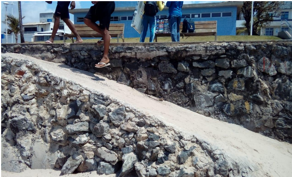
Figura 24 – Fotografia de uma rampa improvisada para o acesso à praia de Itapuã
