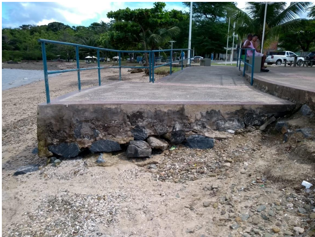
Figura 27 – Fotografia da rampa com um obstáculo ao final para o acesso à praia de Tubarão
