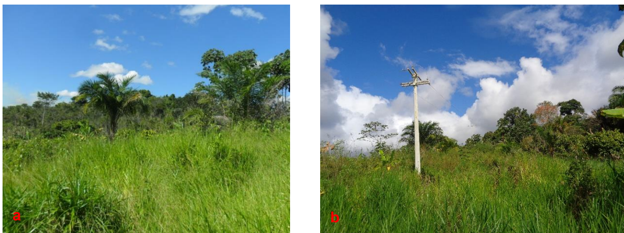
Figura 20: Linha de energia implantada na Comunidade da Região de Antônio Pereira (8_3)
