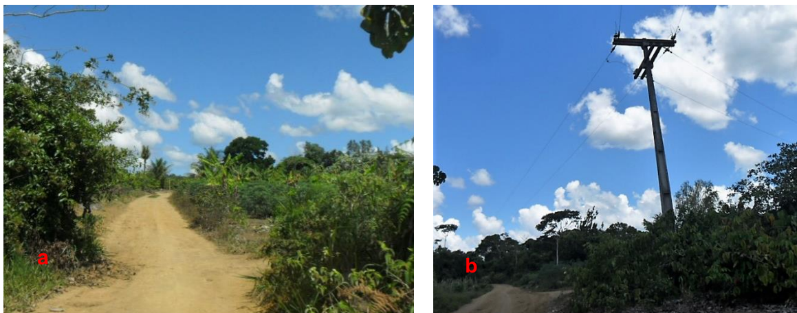
Figura 15: Linha de energia implantada na Comunidade da Região de Antônio Pereira (P8_2), com a realização de supressão da vegetação
