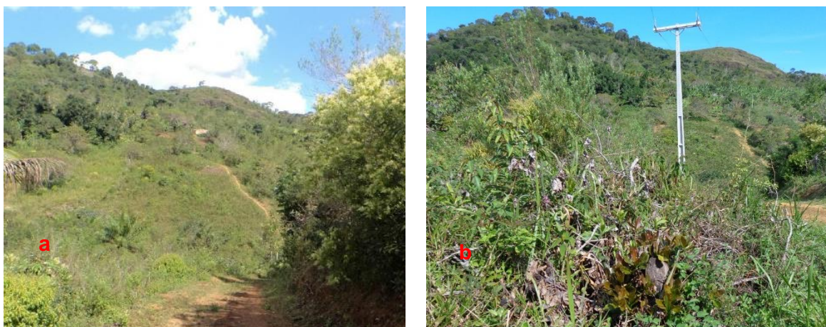
Figura 16: Linha de energia implantada na Comunidade da Fazenda Cantagalo (P6_3), trecho realizada a supressão da vegetação
