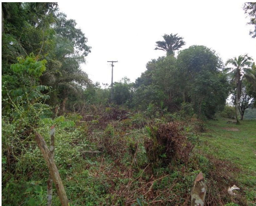
Figura 24: Linha de energia implantada na Comunidade da Região de Antônio Pereira (8_1)
