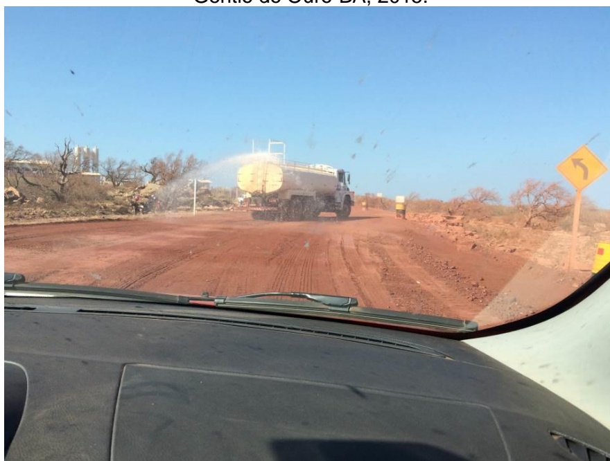
Fotografia 9. Representação da umectação sendo realizada no complexo eólico Assuruá, Gentio do Ouro-BA, 2015.
