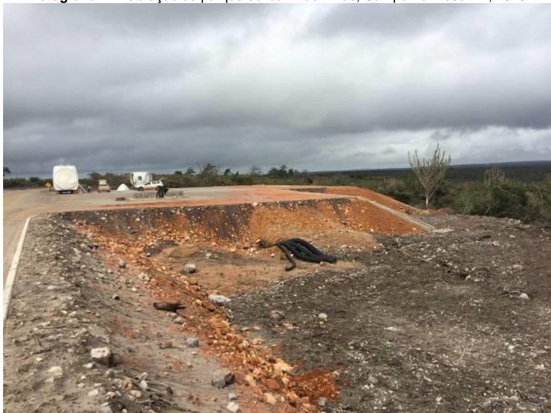
Fotografia 7. Instalação do parque eólico Andorinhas, Campo Formoso-BA, 2015.
