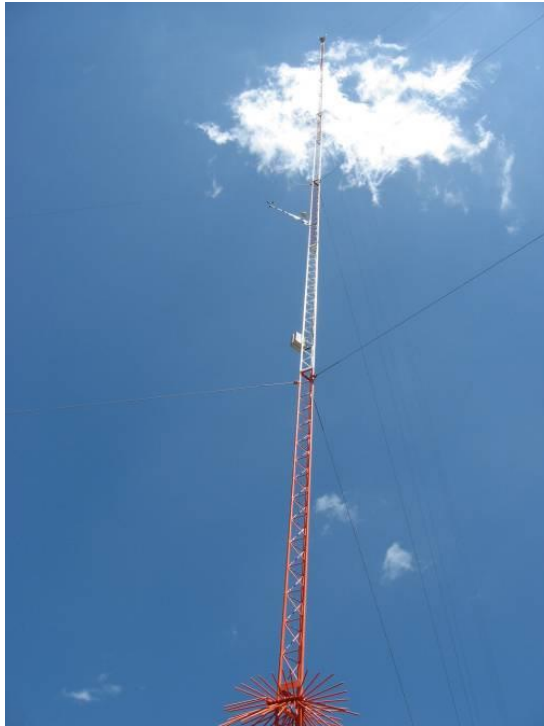
Fotografia 6. Torres anemométricas instaladas em Umburanas – BA, 2016.
