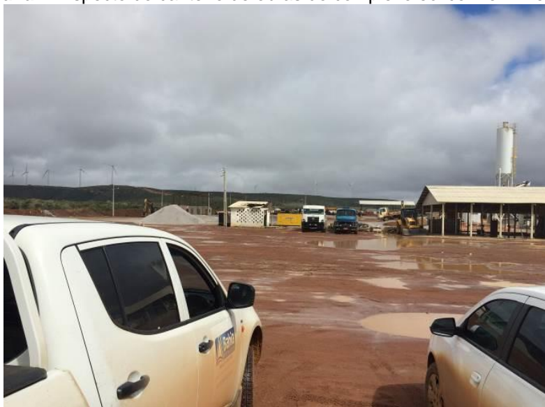
Fotografia 2. Aspecto do canteiro de obras do complexo eólico Morrinhos, 2014.
