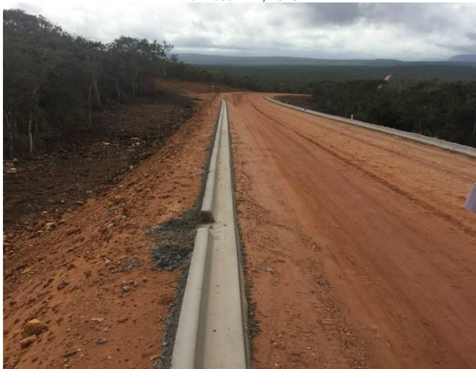
Fotografia 1. Aspecto do acesso interno contemplando sistema de drenagem pluvial. Campo Formoso –BA, 2015.
