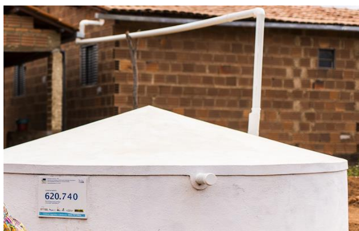
Fig. 18 – Cisterna construída no Município de Uauá
