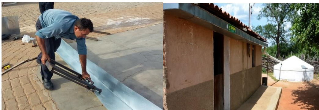
Figs. 21-22 – Produção e instalação de calha de flandres sob o telhado para o abastecimento das cisternas
