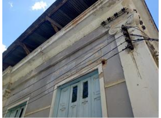
f. Vigas de sustentação do anexo III
