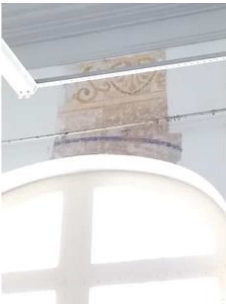
c. Prospecção demonstrando pintura original da parede de um dos salões do prédio principal, antes da reforma.
