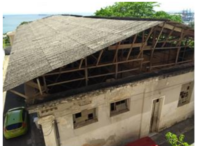
d. Vista superior do Anexo III, único prédio não tombado, utilizado atualmente pelos funcionários da UFBA como copa.
