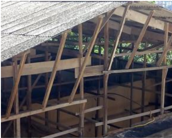
g. Estrutura de cobertura do anexo III.
