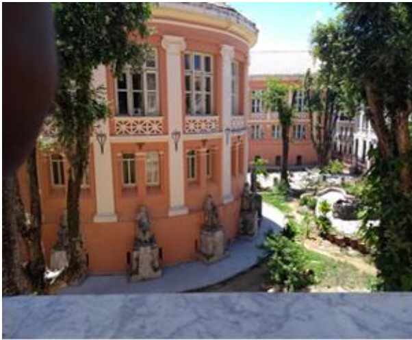
a. Vista do edifício principal da FAMEB
