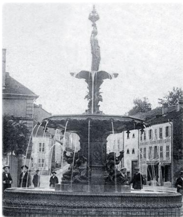
Figura 13 – Chafariz instalado na Praça do Comércio 60
