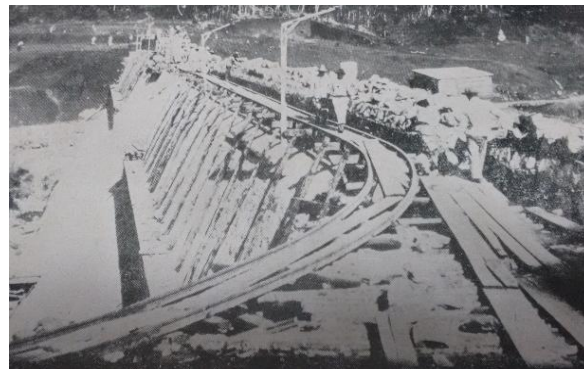
Figura 16 - Vista da barragem do Rio do Cobre em construção, 1930
