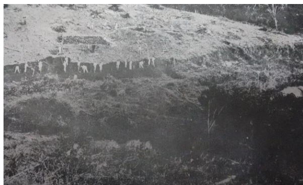
Figura 15 - Início da construção da barragem do Rio do Cobre, 1929.
