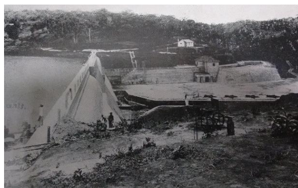
Figura 18 - Vista do conjunto da barragem, tratamento químico e decantação, 1932. (FERNAL, 1936).
