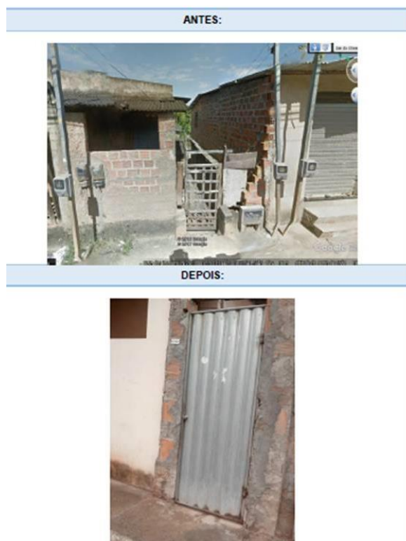
Figura 5 – Fachada da casa de número 12-037 do programa antes e depois da intervenção
