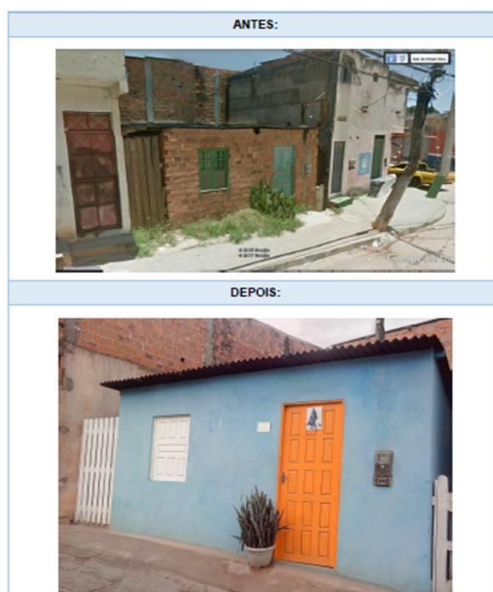
Figura 4 – Fachada da casa modelo do programa antes e depois da intervenção
