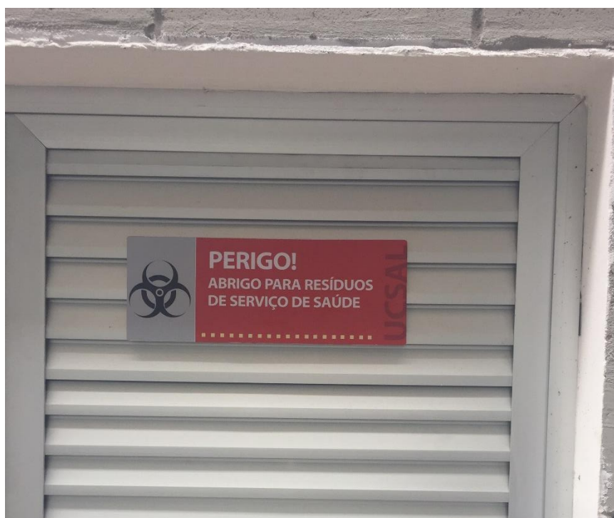
Figura 18 - Local de armazenamento dos resíduos de Saúde – UCSAL
