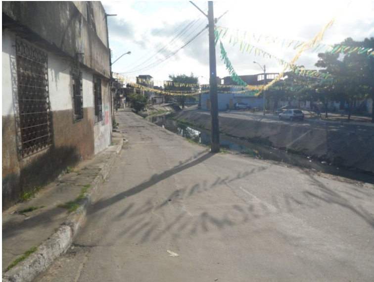
Figura21– Canal do Rio Paraguari construído na gestão municipal de Lídice da Mata
