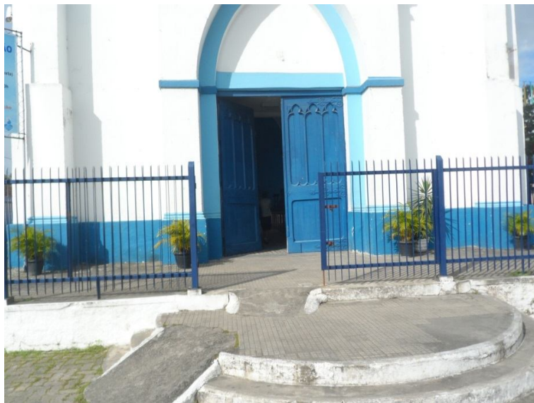
Figura 23 - Igreja de N.S. da Conceição da Praia - Periperi Local de participação na luta pela drenagem do Rio Paraguari.
