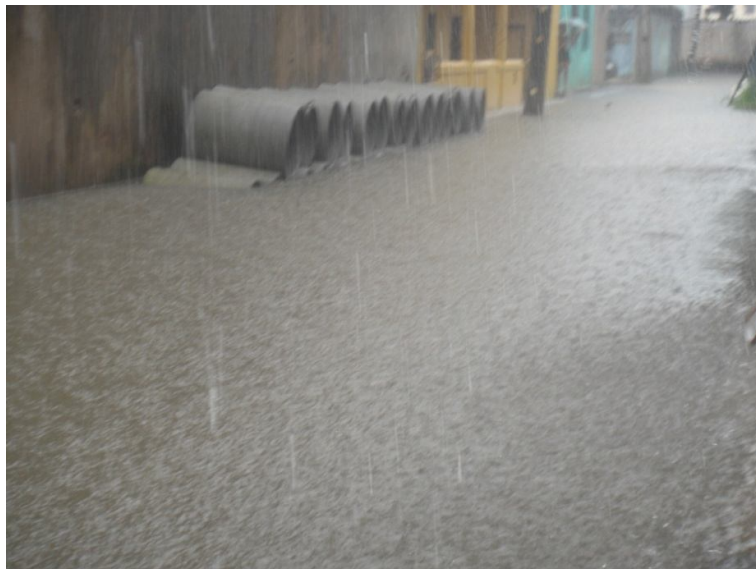
Figura 15 – Rua Monte Sião alagada – Conjunto D. Eugenio Sales (Periperi) – 2014
