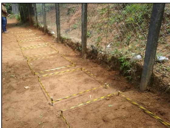
Figura 9 – Limpeza e demarcação dos locais de tratamento
