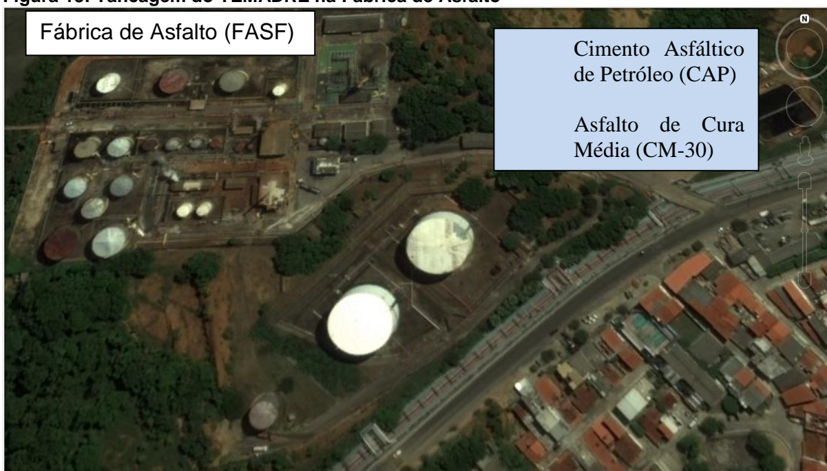
Figura 13: Tancagem do TEMADRE na Fábrica de Asfalto
