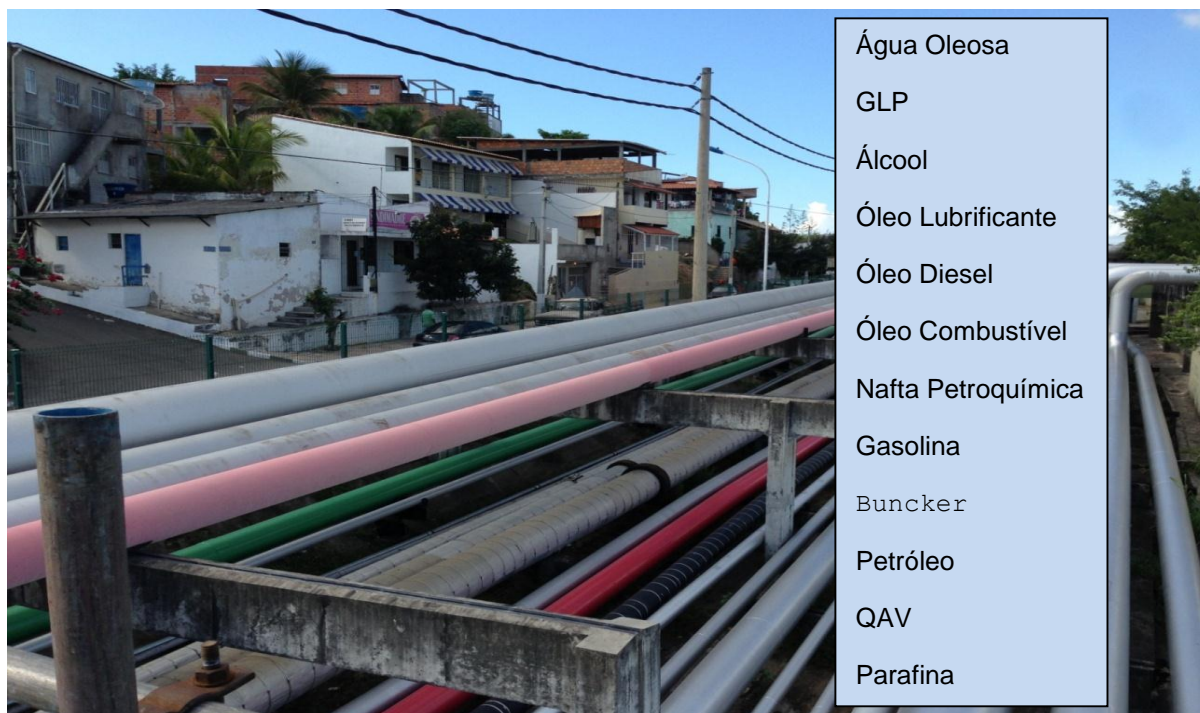
Figura 15: Trecho da faixa de domínio da dutovia
