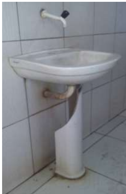
Figura 12 – Pia do banheiro
