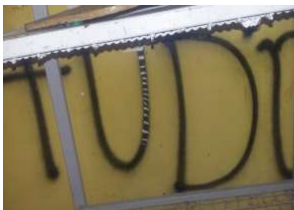
Figura 9 – Parede da sala de aula
