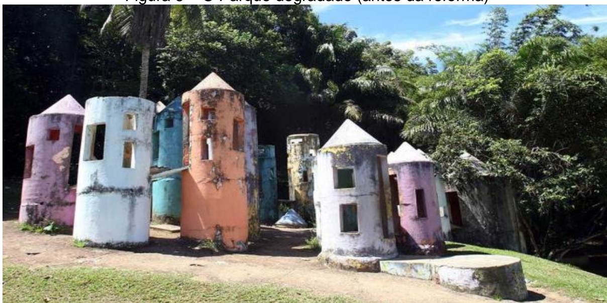
Figura 6 – O Parque degradado (antes da reforma)
