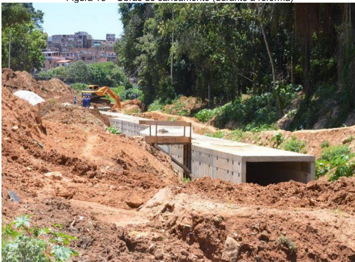
Figura 16 – Obras de saneamento (durante a reforma)
