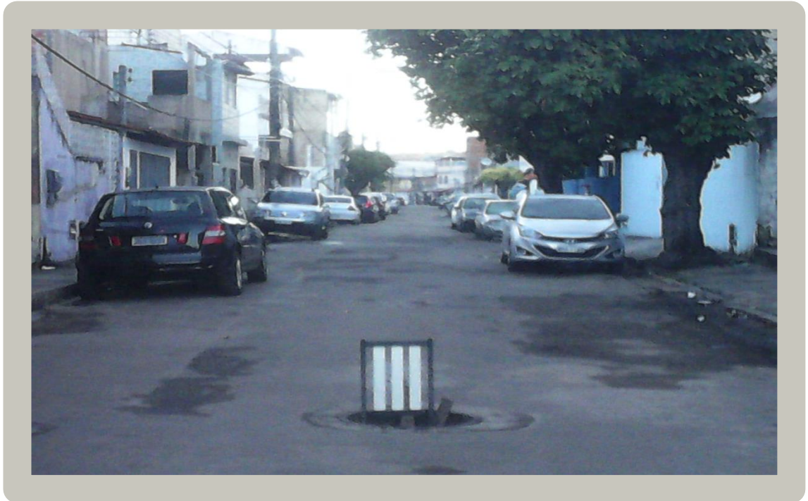
Figura 14 - Boca de Lobo com RSU (cadeira) atravessada no meio de uma rua no bairro do Jardim Cruzeiro na cidade baixa em Salvador
