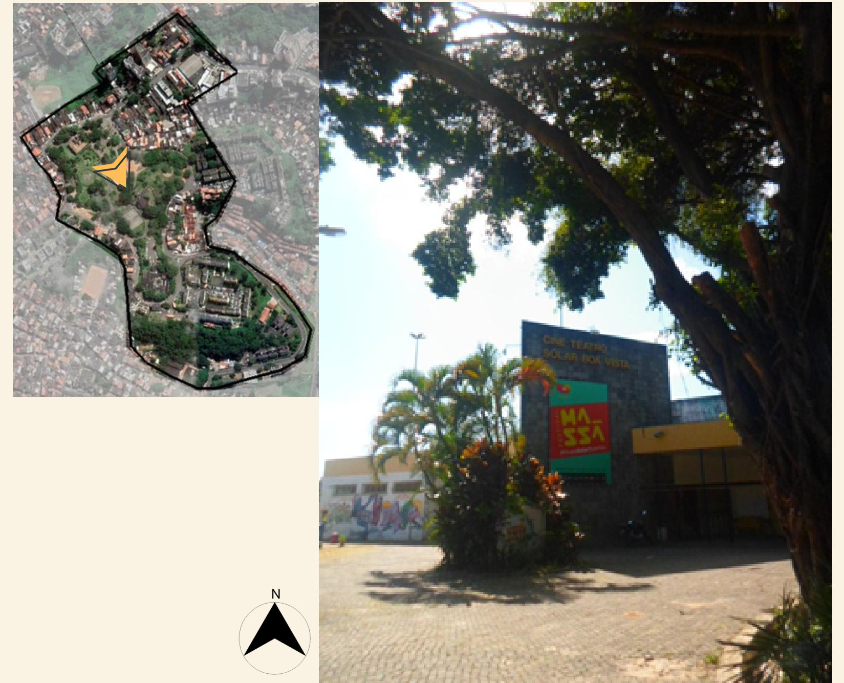
Figura 63: Fachada do Cine Teatro Solar Boa Vista
