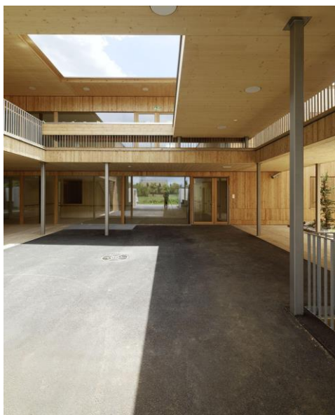
Figura 26 - Estrutura de Madeira.
