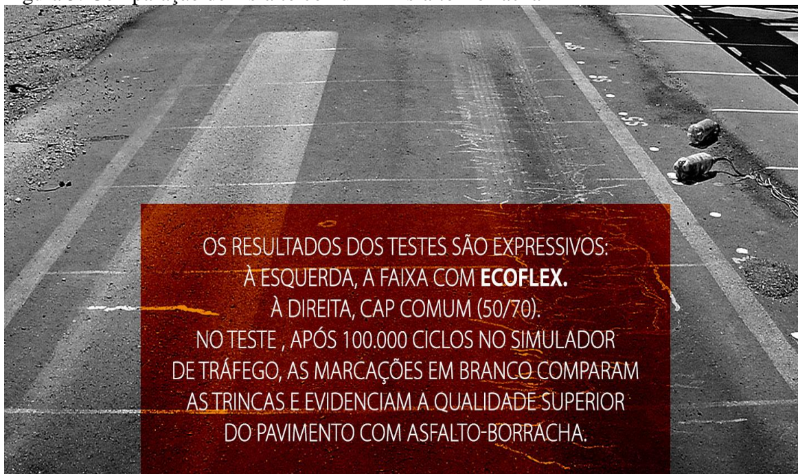
Figura 5: Comparação de Asfalto comum x Asfalto Borracha
