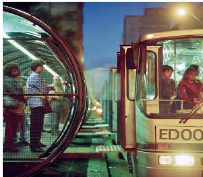
Figura 1 – Plataforma elevada de embarque
