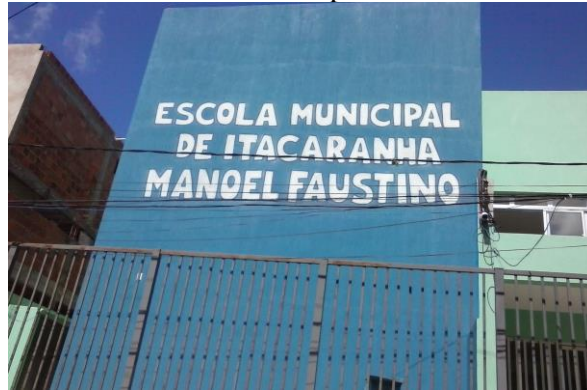
Figura 19 – Fachada da Escola Municipal de Itacaranha Manoel Faustino
