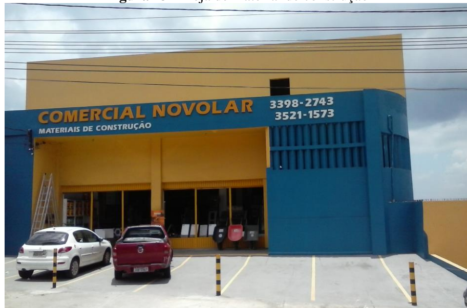
Figura 43 – Loja de material de construção
