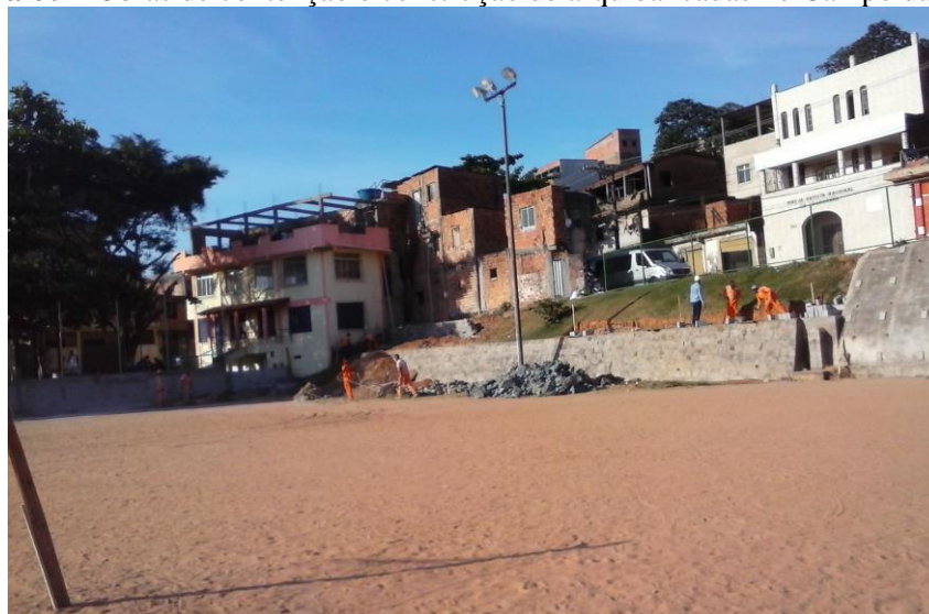
Figura 60 – Obras de contenção e construção de arquibancadas no Campo da Lagoa
