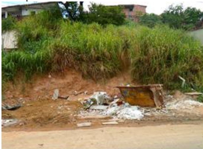
Figura 63 – Barranco e lixo espalhado - cruzamento da Avenida Maravilha com a Rua Teskey
