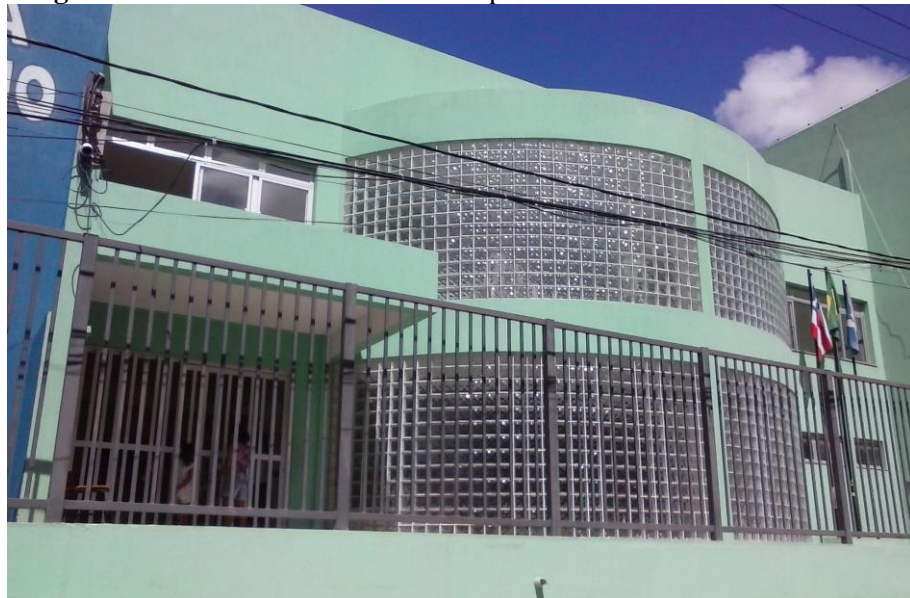
Figura 46 – Fachada da Escola Municipal de Itacaranha Manoel Faustino
