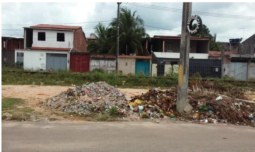
FIGURA 33 –PEV Nº 7 desativado no bairro Novos Horizontes em 2016 Fonte: Pesquisa de campo (2016).
