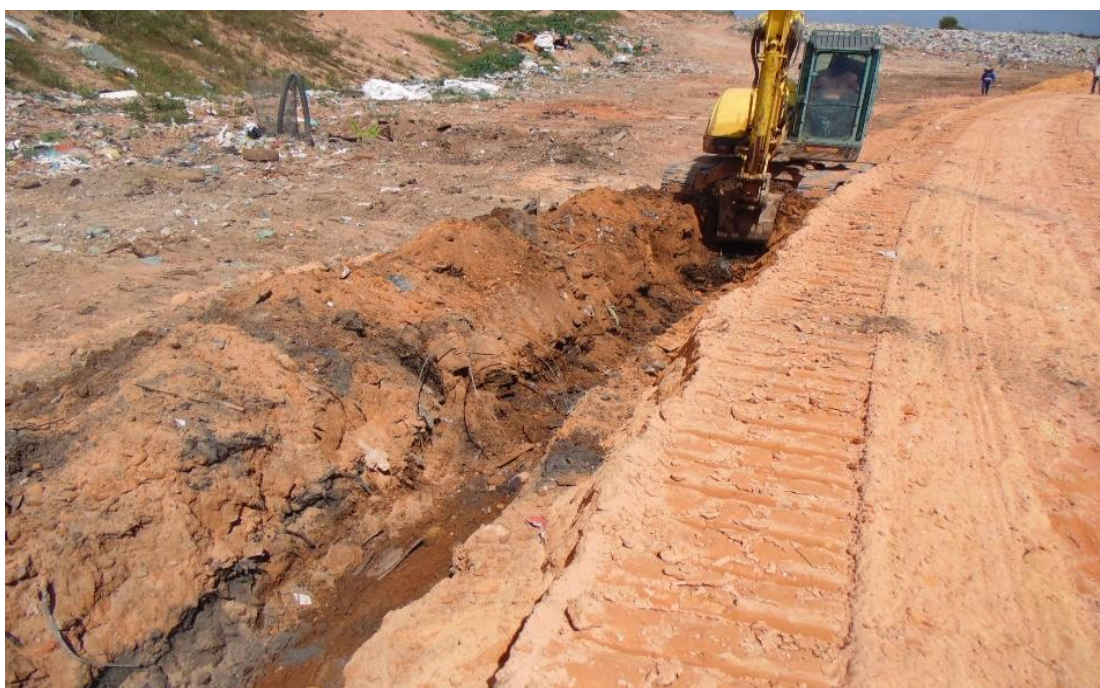
FIGURA 43 – Aberturas de valas para construção de drenos
