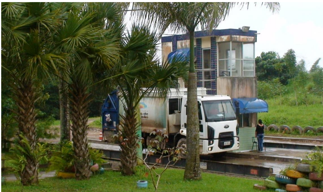
FIGURA 40 – Balança na entrada do aterro sanitário no município de Camaçari/BA, 2015
