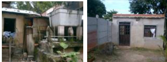
Figura 2 – Fotos de moradias mostrando o armazenamento de água e a iluminação artificial
