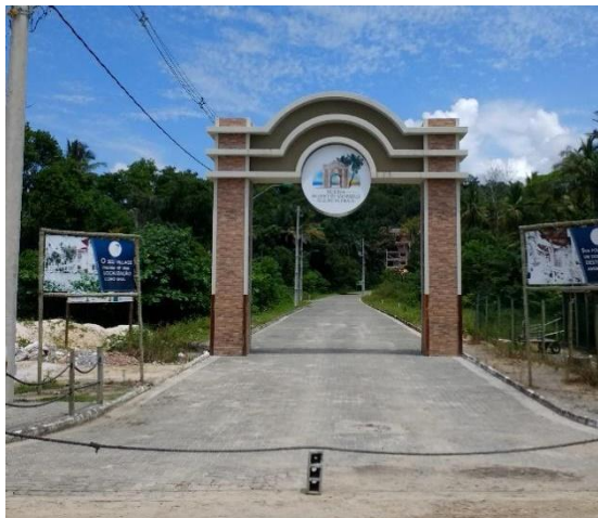
Figura 22: Entrada do condomínio em construção na localidade de Morro de São Paulo – Cairu/BA
