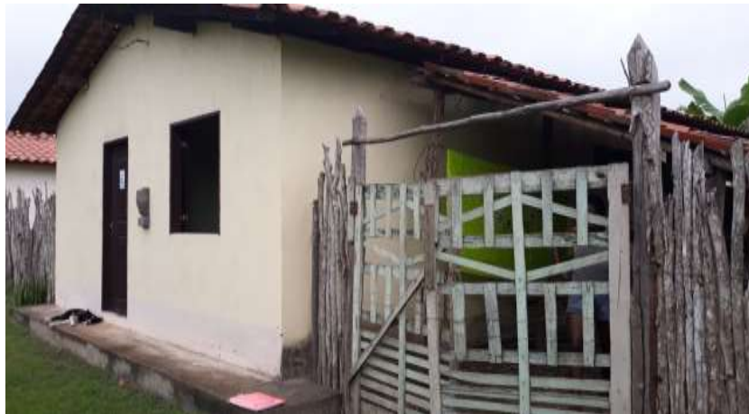
Fotografia 19 - Puxada na lateral da nova moradia
