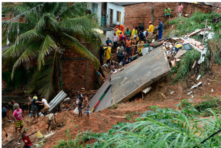
Figura 2: Deslizamento de terra no bairro Fazenda Grande do Retiro
