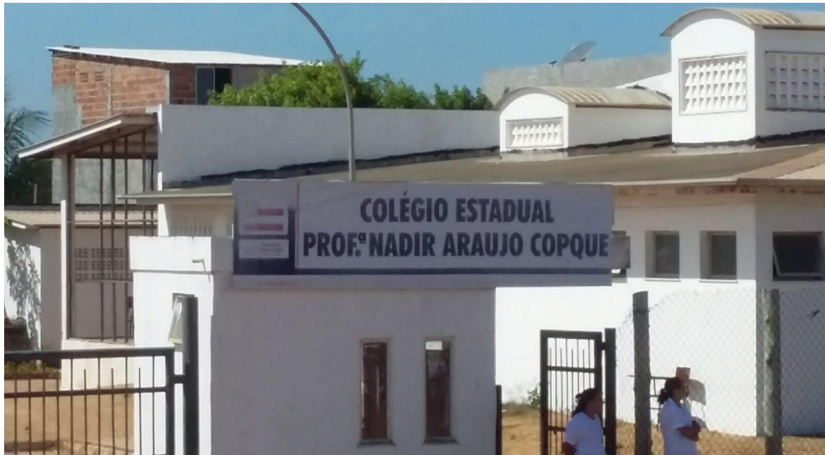
Figura 3 – Fachada Colégio Estadual Professora Nadir Araújo Copque.
