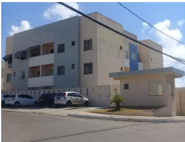
Figura 15 – Verticalização entre a Rua Maria de Lourdes Cidreira e a Rua Antônio Davi Mota.
