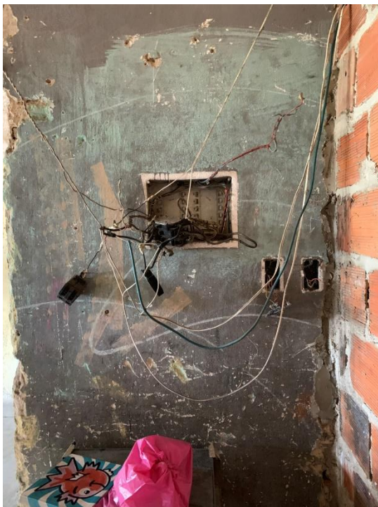
FIGURA 10: Fiação de luz exposta e o banheiro coletivo
