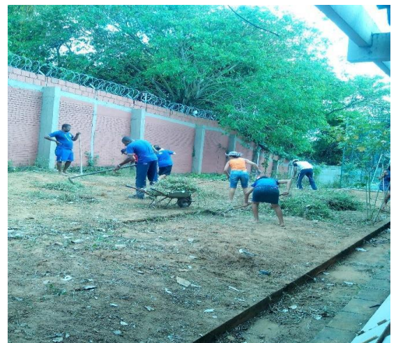
Figura 4 - Preparação do terreno
