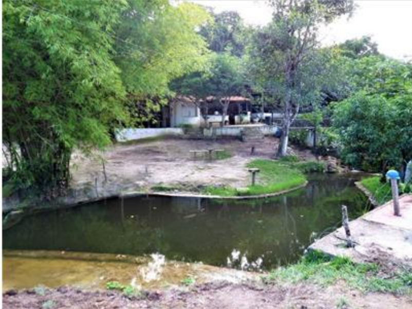
Fig. 07 - Bar construído irregularmente em APP
