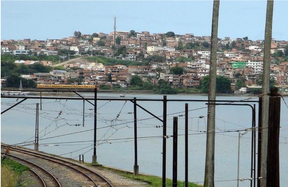
Figura 11 – Vista da Estação Almeida Brandão, em Plataforma
