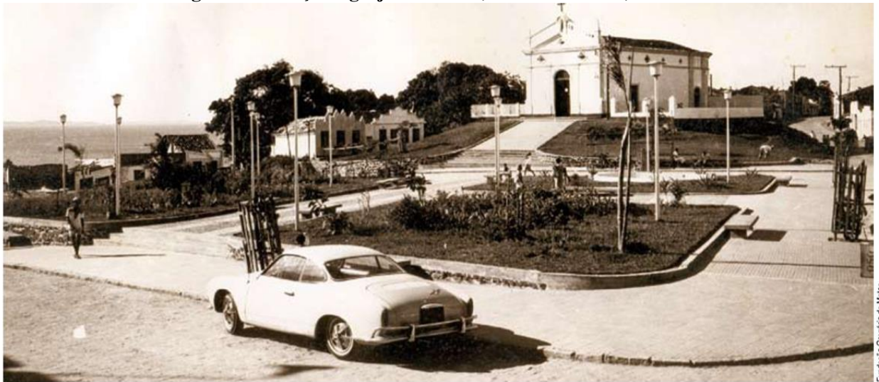
Figura 8 – Praça e Igreja São Braz, em Plataforma, 1971
