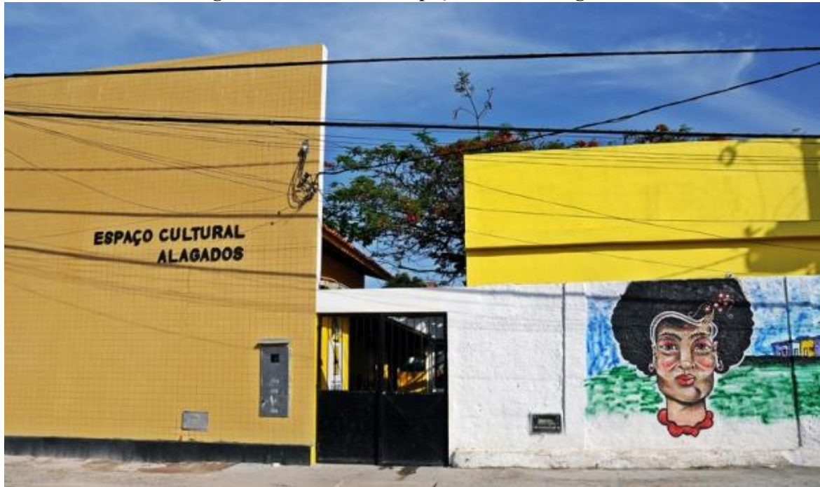
Figura 2 – Fachada do Espaço Cultural Alagados
