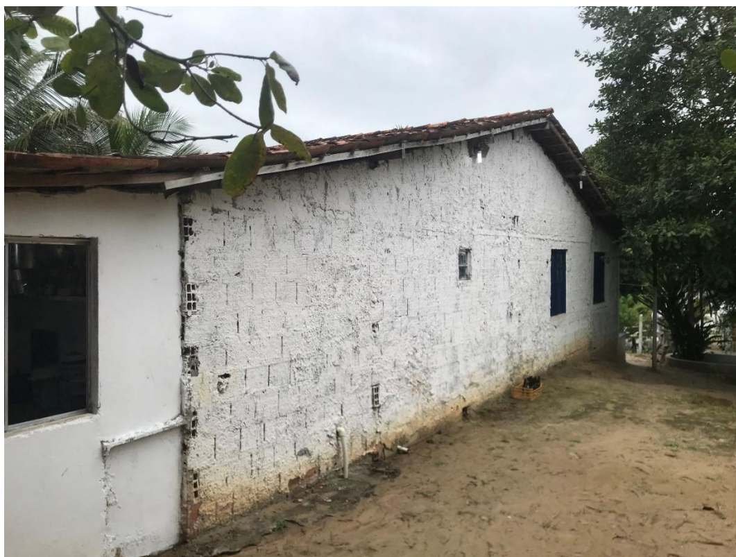
Figura 88 e 89 – Vistas da fachada lateral do terreiro.
