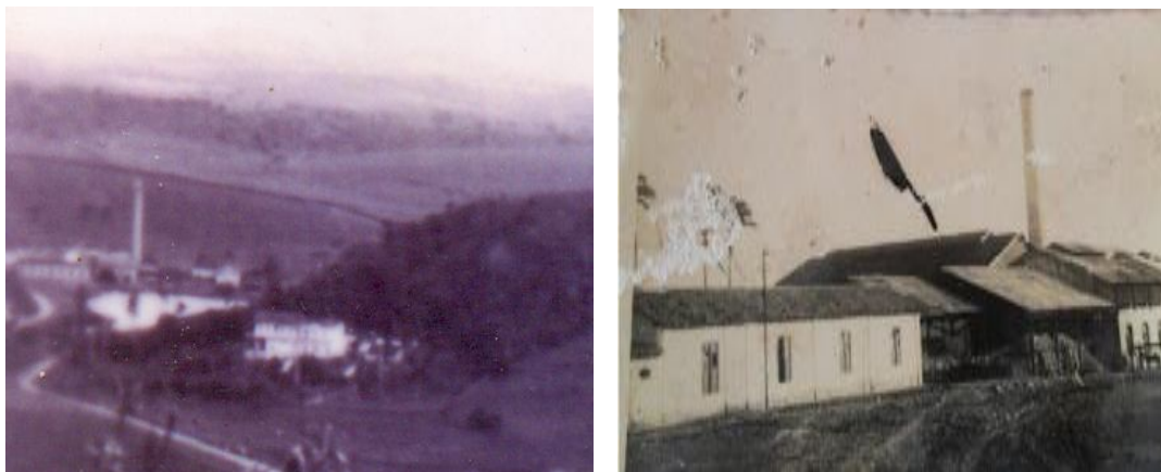
Figura 7- Usina de São Bento no município de Amélia Rodrigues – 1950
