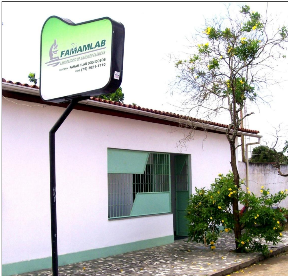
Figura 10 – Prédio do Laboratório de Análises Clínicas – FAMAMLAB, na cidade de Cruz das Almas – 2013
