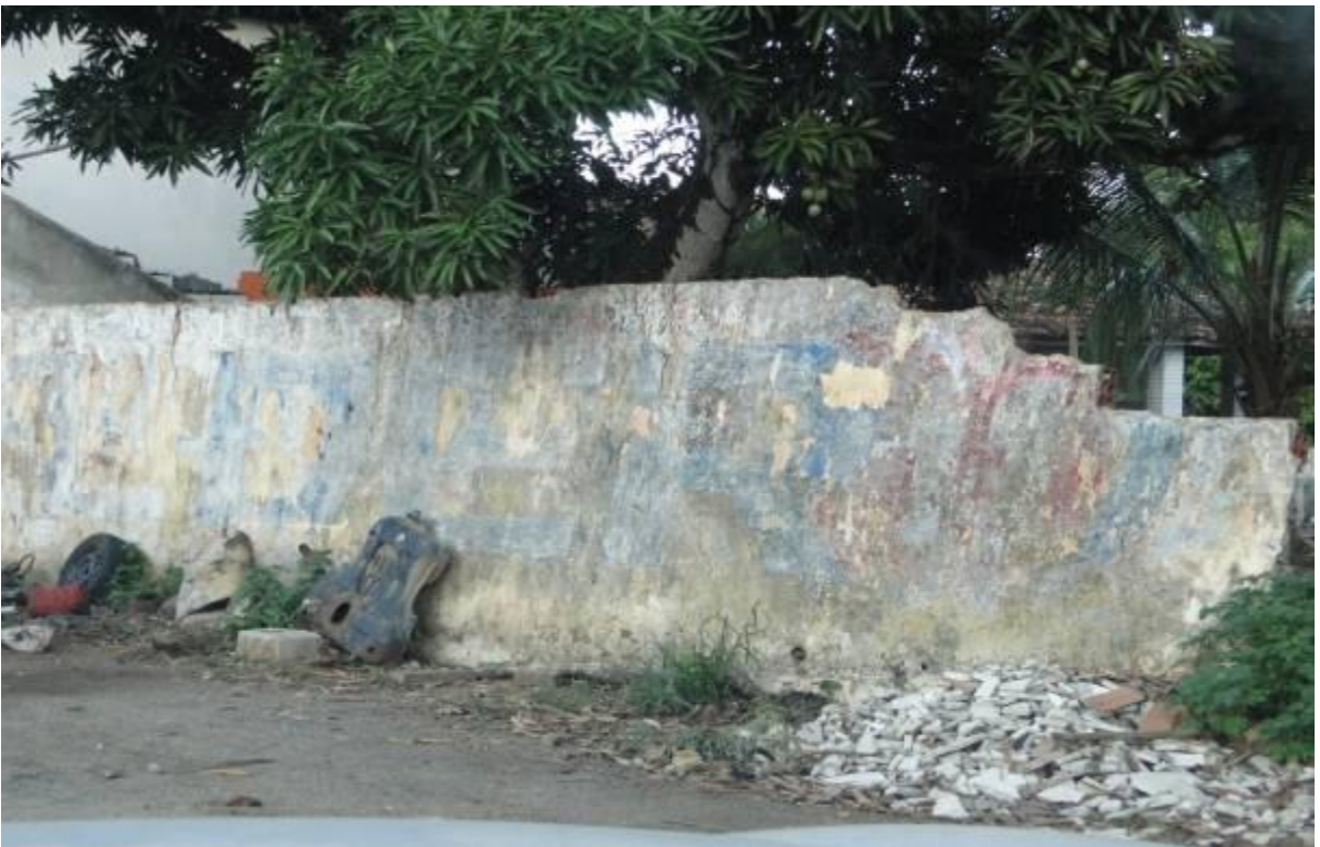
Figura 25 – Acúmulo de entulho
