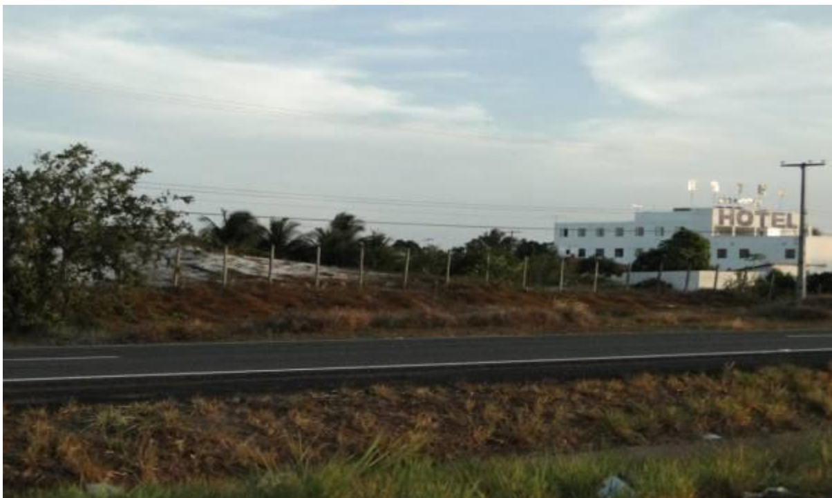
Figura 16 – Construção de empreendimentos sobre dunas em Guarajuba
