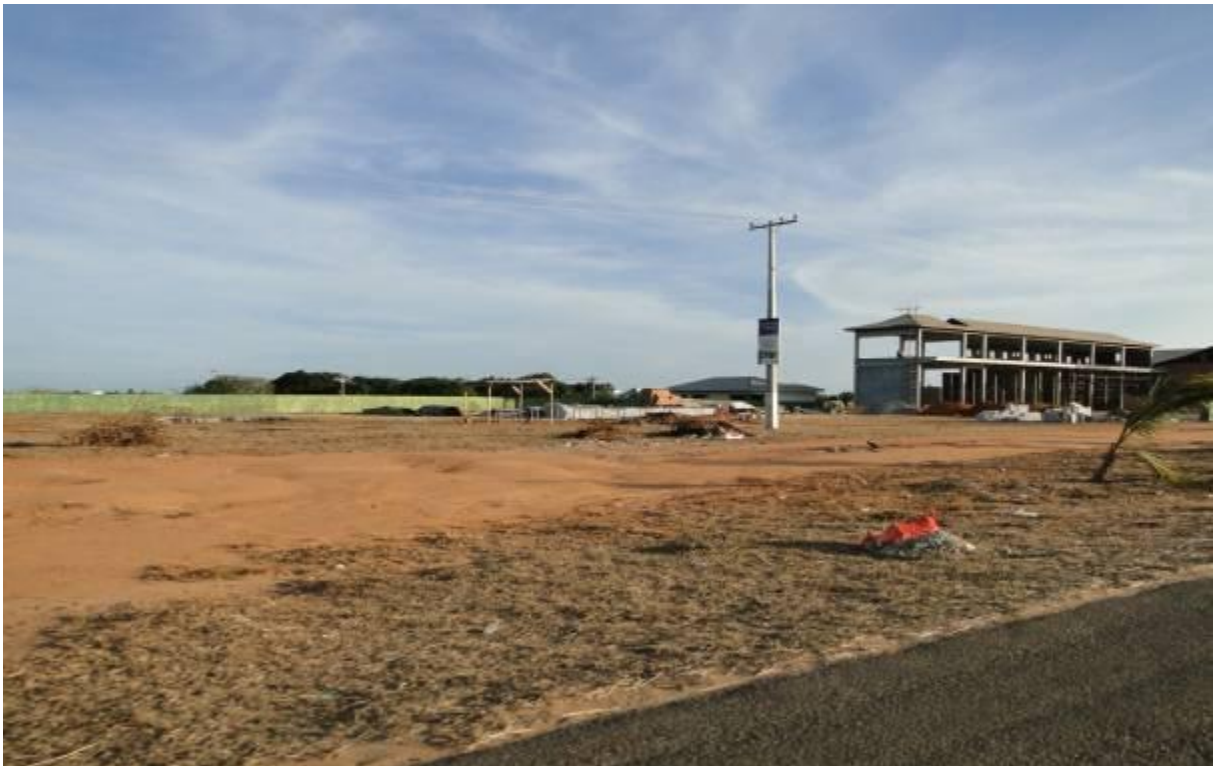
Figura 18 – Construção de Shopping entre Guarajuba e Itacimirim
