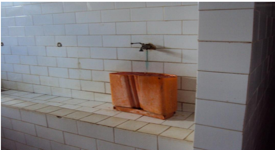
Figura 15 Banheiro da ESARM Fonte: Dados da Pesquisa, 2013.
