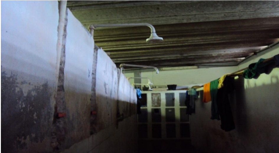
Figura 14: Banheiro da ESARM. Fonte: Dados da Pesquisa, 2013.
