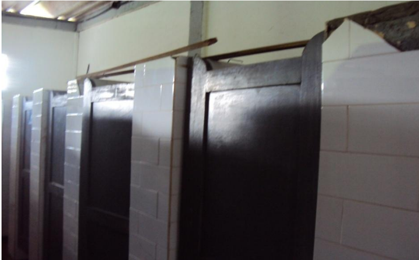
Figura 16: Banheiro da ESARM Fonte: Dados da Pesquisa, 2013.
