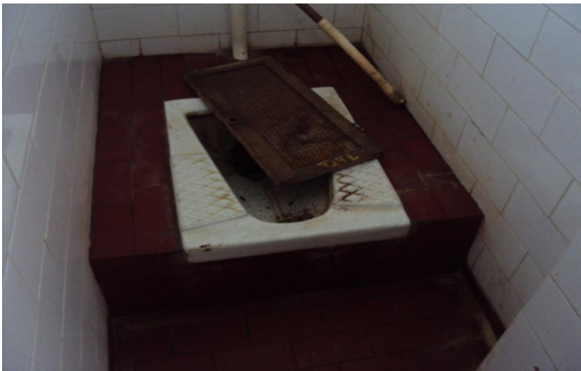
Figura 17: Banheiro da ESARM Fonte: Dados da Pesquisa, 2013.
