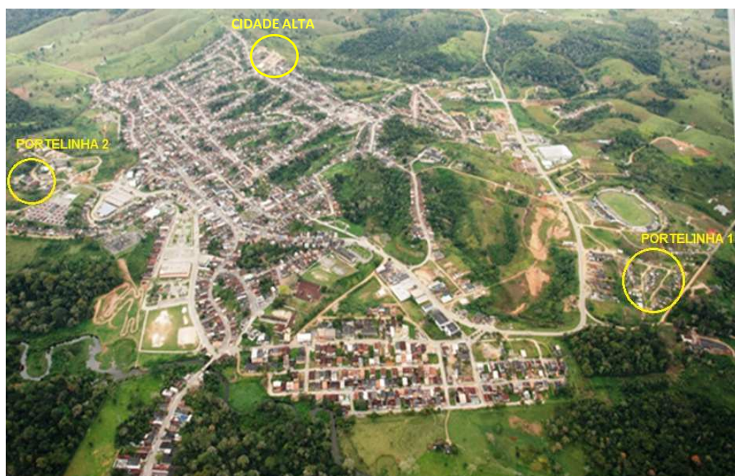
Figura 08 – Foto aérea da cidade de Camacã/BA
