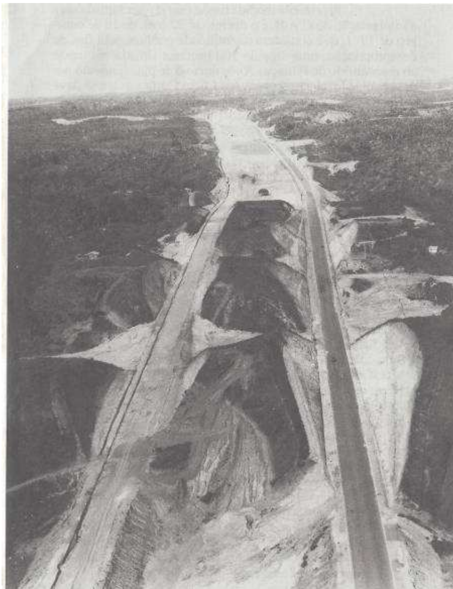
Figura 7 - Avenida Paralela em construção Salvador/BA – 1971
