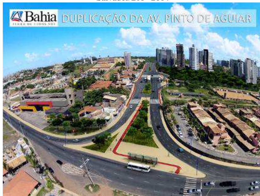
Figura 15 – Duplicação da Avenida Pinto de Aguiar Salvador/BA - 2014
