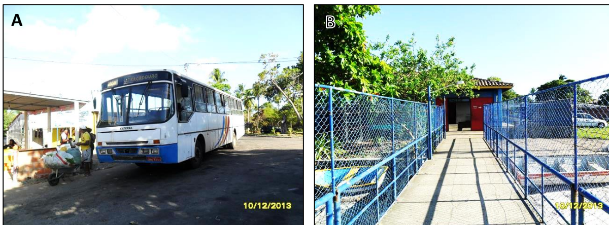
Figura 29: (A) Área externa ao atracadouro e infraestrutura de apoio; (B) Terminal do atracadouro Fonte: Pesquisa de Campo, 2013.
