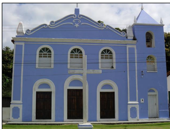
Figura 89: Igreja de São Sebastião Fonte: Pesquisa de campo, 2013.
