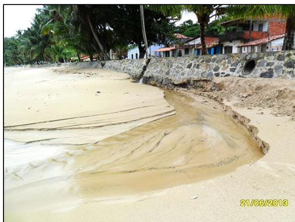
Figura 82: Despejo de água pluvial, fluvial e dejetos domésticos na praia. Fonte: Pesquisa de campo, 2013.
