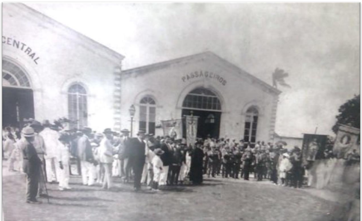
Figura5– Estação Rodoviária em 1950 no fundo da Igreja da Matriz
