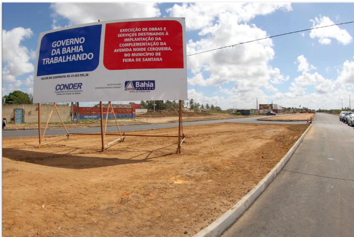
Figura37- Obras da Av. Nóide Cerqueira que ligará Av. Getúlio Vargas a BR 324 - um novo vetor imobiliário.
