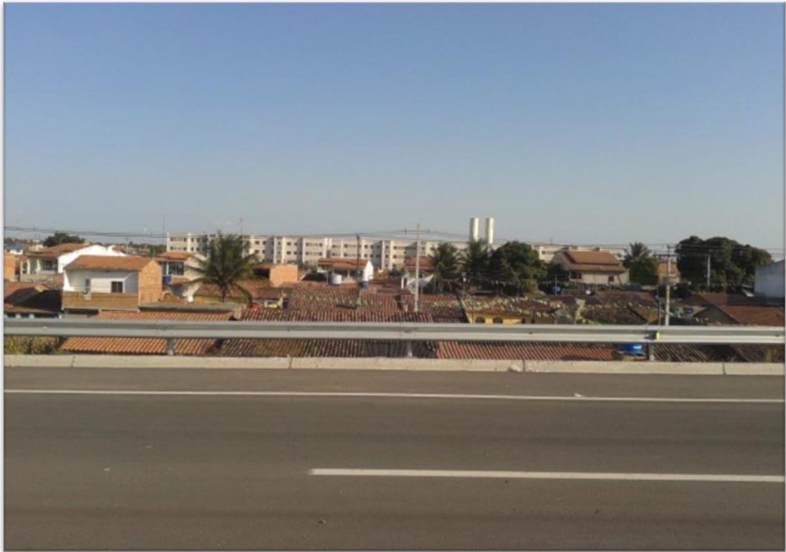
Figura51- Tomba II - Vista do viaduto da Av. Eduardo Fróes da Mota
