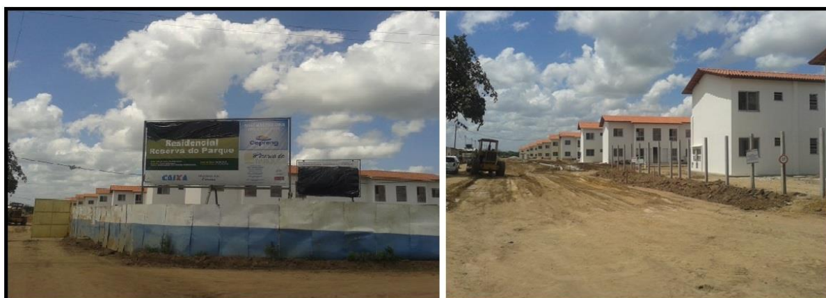
Figura 78- Residencial Reserva do Parque, em obras
