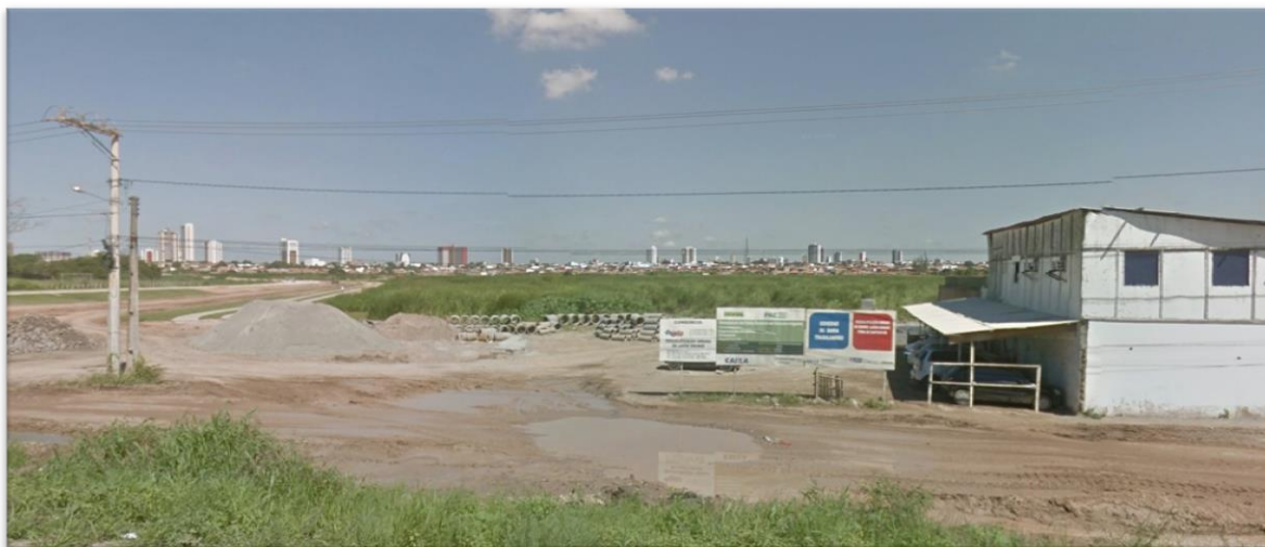
Figura67-Lagoa Grande ainda em obras em 2014– Bairro Lagoa Grande
