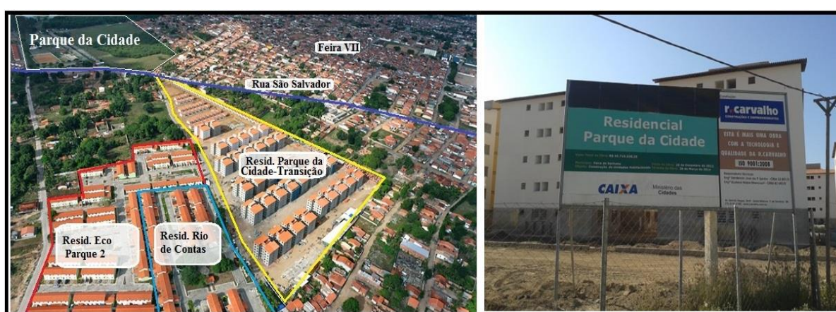
Figura 77- Residencial Parque da Cidade Transição, em obras
