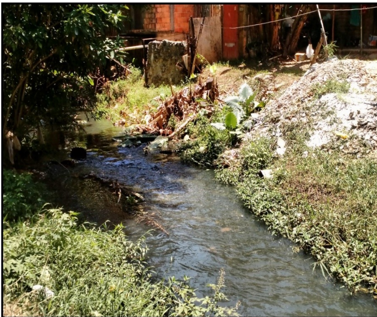
Figura 10- Ausência de rede coletora de esgoto na Comunidade do Bate Facho
