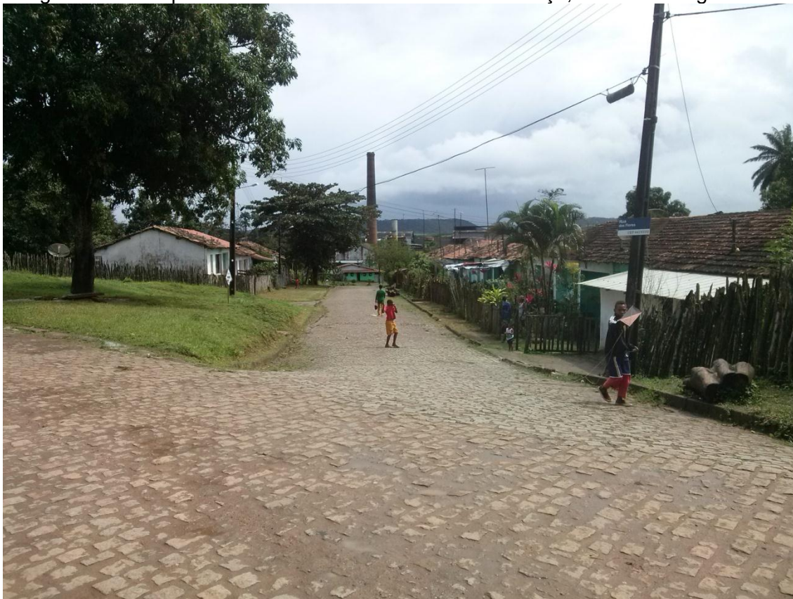
Figura 24 - Rua pavimentada no distrito de Mata da Aliança, Amélia Rodrigues-BA
