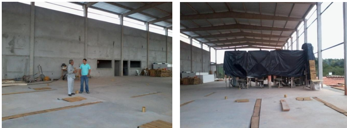
Figura 48 – Instalação das máquinas e construção predial da fábrica Alina do Brasil S.A – 2011
